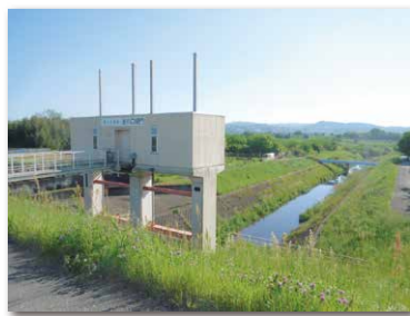
⑭ 生れ口樋門
