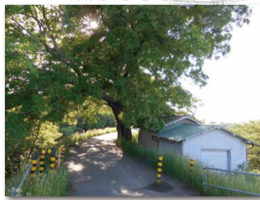
⑪ 水防倉庫(東富野)
