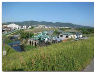
⑬ 生れ口排水機場
