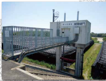
② 城陽樋門
