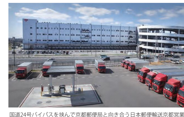
国道24号バイパスを挟んで京都郵便局と向き合う日本郵便輸送京都営業所
