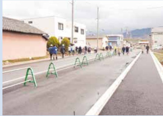
▲山城青谷駅周辺道路整備箇所を視察。写真は新青谷線
