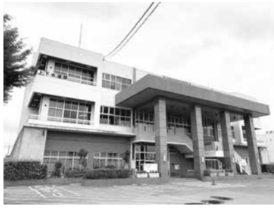
▶耐震補強工事が行われる上下水道部庁舎・北部コミセンの複合施設
