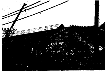
屋根・屋上防水改修
