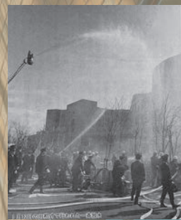
▲平成9年の消防出初式では文パルに向かって一斉放水
