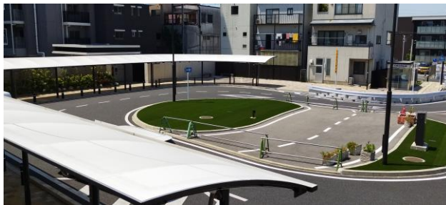
図 2.15: 寺田駅西口広場
