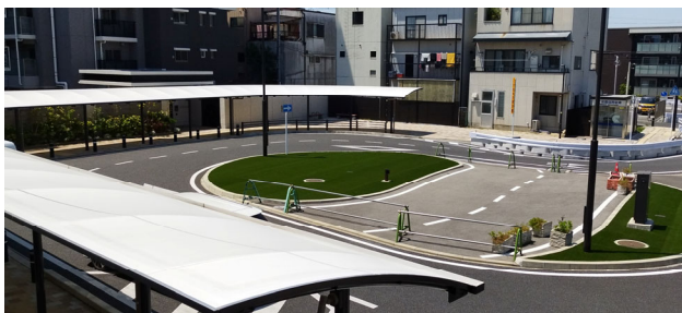
▲寺田駅西口広場
