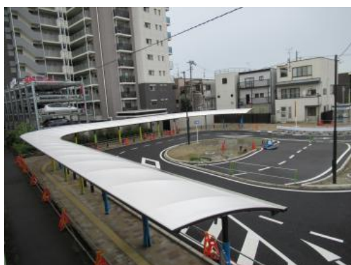
図 2.14: 寺田駅西口広場
