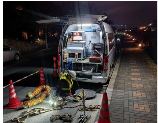
▲下水道管の調査
