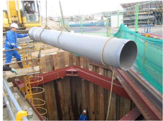
▲水道管の耐震化
