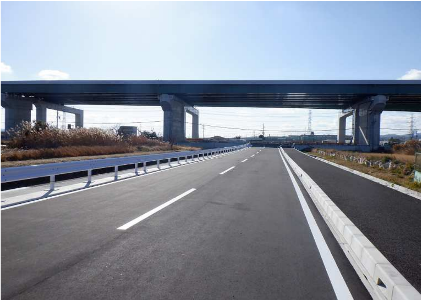
府道内里城陽線と国道24号を南北に繋ぐ市道5号線
