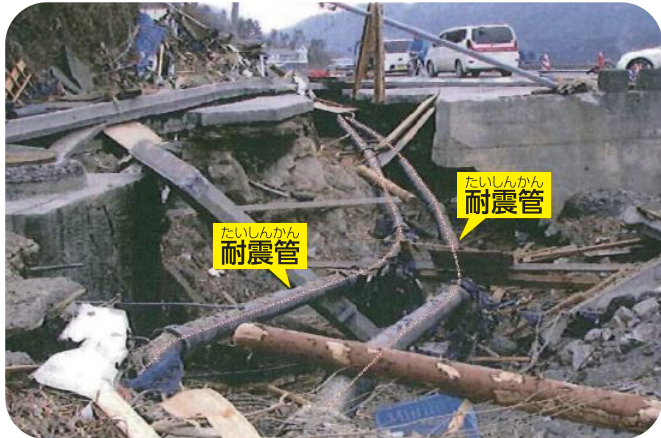
東日本大震災の津波による道路崩壊 耐震管により機能の損失を回避
