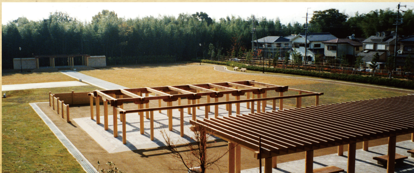
整備後の正道官衙遺跡
