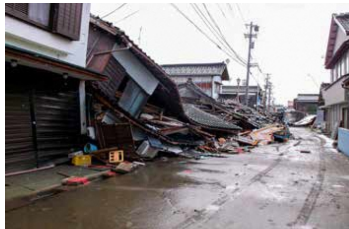
▲令和6年能登半島地震の被害状況
