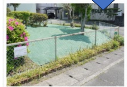
防草シート施工後1
