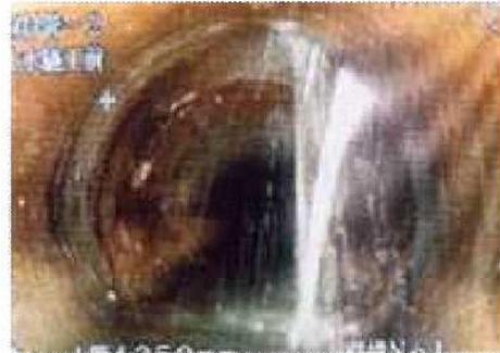
図 3-7 管路施設への浸入水※1
