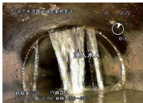
図5-4 管内の浸入水の状況例
