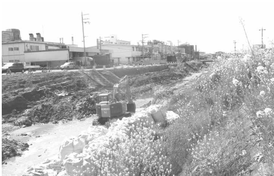
改修が進められる古川
