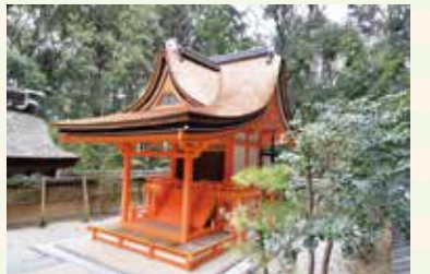
▲修理を行った水度神社
