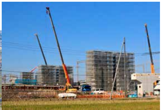
▲建設が進む新名神高速道路 ◀城陽IC上空から(提供: NEXCO西日本)
