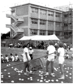
▲新校舎(北校舎。右は工事中の渡り廊下)
