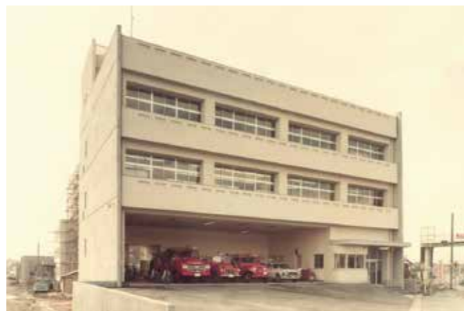
城陽町消防本部消防署庁舎新築移転
