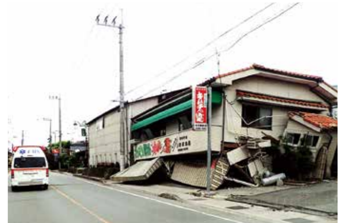
熊本地震(被災状況)
