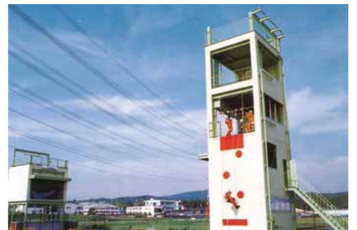
消防訓練塔竣工
