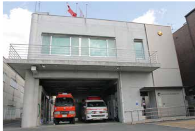
久津川消防分署設置
