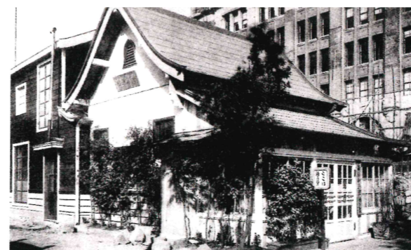
③ 関東大震災後に再建された京橋鴻乃巢 『建築写真類聚』 大正12年12月
