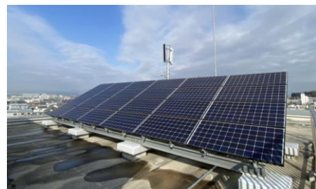
市役所西庁舎屋上の太陽光パネル
