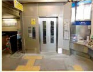
近鉄富野荘駅では、改札内の内と外を自動的に振り分けられる構内外併用型エレベーターの設置・多機能トイレの改修・視覚障がい者がホーム側と線路側を認識でき、転落防止につながる内方線付き点状ブロックの設置などの工事が3月に完了し、身体に障がいのある人やお年寄り、ベビーカーを利用する人にとってより便利になっています。
