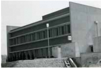
▲完成した城陽電報電話局 (昭和43年)
