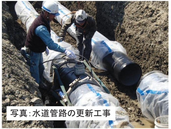
写真:水道管路の更新工事
