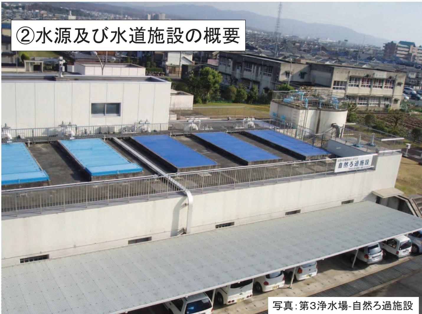
写真：第3浄水場-自然ろ過施設
