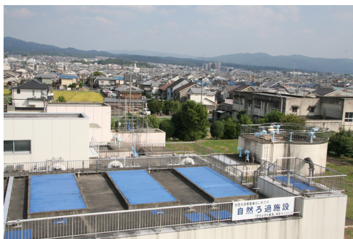
自然ろ過施設
