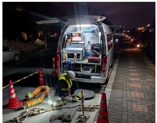
▲下水道管の調査
