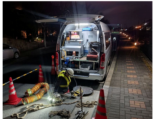
▲下水道管の調査
