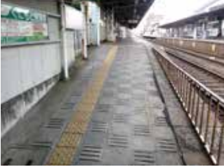
▲スロープ整備前 (勾配12%)
