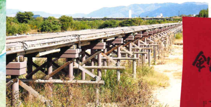
流れ橋(八幡市側から)
