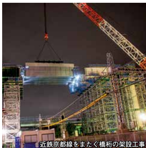
近鉄京都線をまたぐ橋桁の架設工事
