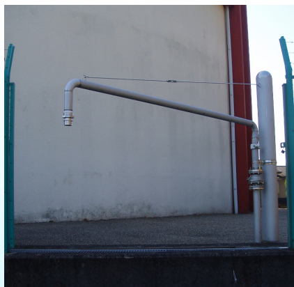
図 6-6 給水車両の給水栓
