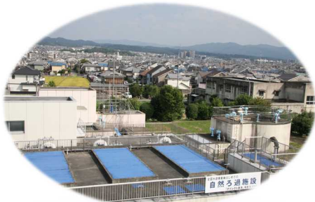
自然ろ過施設
