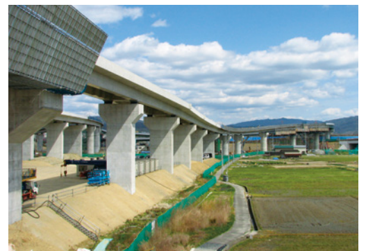
建設中の新名神高速道路。木津川のあたり
