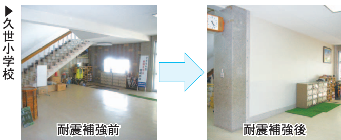
鉄筋コンクリートを使い壁を新しく作った補強
