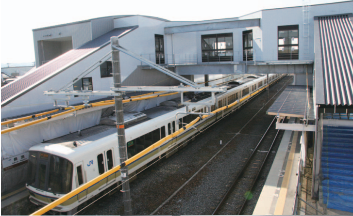
橋上化した 新駅舎
