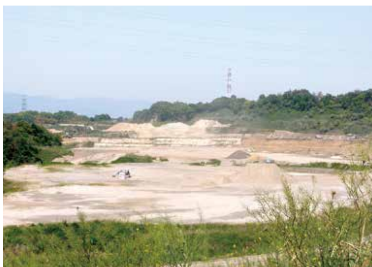
▲埋め戻しが進む東部丘陵地長池地区
