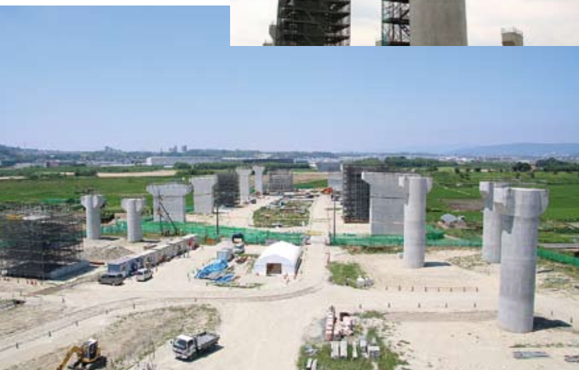
▲着々と整備の進む新名神高速道路城陽JCT・IC(仮称)の橋脚工事。橋脚37基中16基が完成しています
