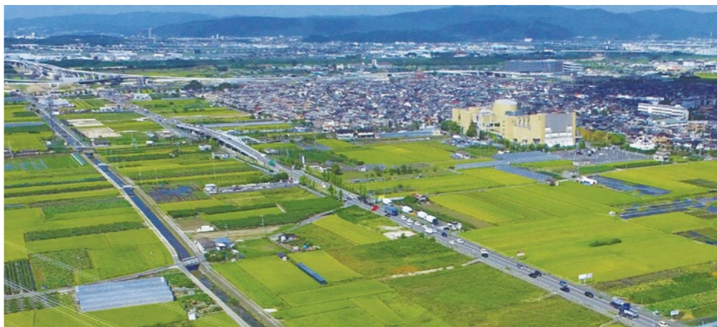
写真の中央を通るのが国道24号で、ここに新名神高速道路が通り、両脇に国道24号が整備される。奥が城陽JCT・ICに
