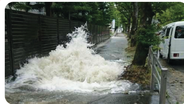
◆大阪府北部地震による水道管損壊事例 出典:大阪広域水道企業団
