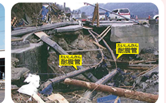
◆東日本大震災の津波による道路崩壊 耐震管により機能の損失を回避
