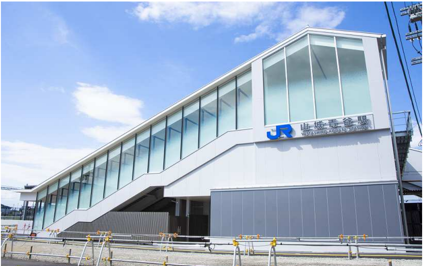
令和4年7月に完成した山城青谷駅橋上駅舎
