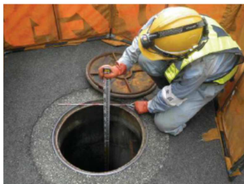
図 3-18 マンホール調査の様子(本市)
