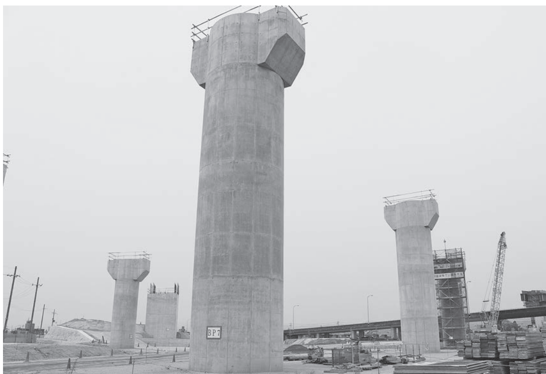
現在工事が進んでいる新名神高速道路
