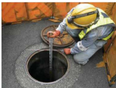
図 3-18 マンホール調査の様子(本市)
