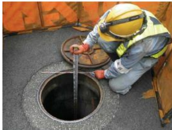
図 3-15 マンホール調査の様子（本市）
