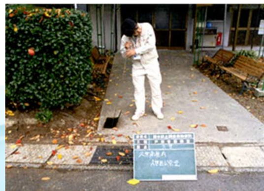
図 6-8 漏水調査
