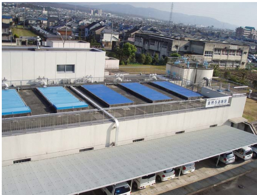
図 4-13 自然ろ過施設（第三浄水場）
