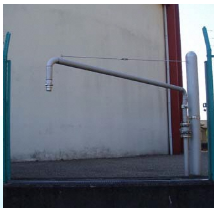
図 6-6 給水車両の給水栓
