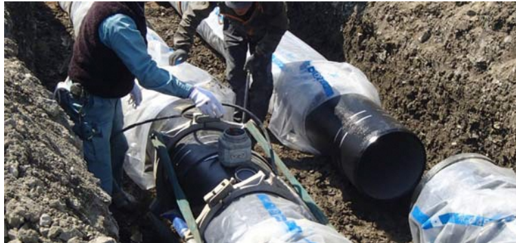
図 6-5 耐震管工事
