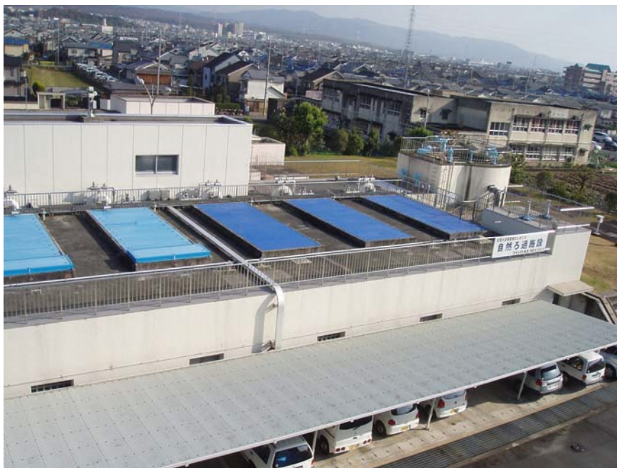
図 4-13 自然ろ過施設（第三浄水場）
