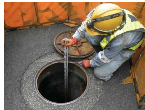
< マンホール状況調査 >
