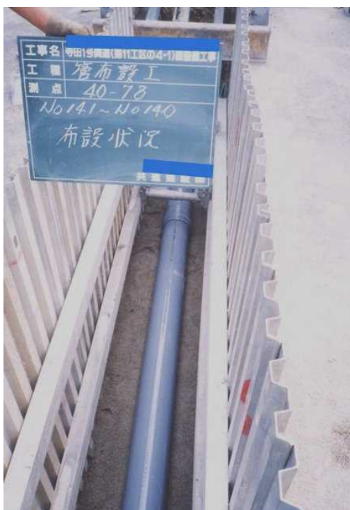
< 下水道管敷設写真 >
